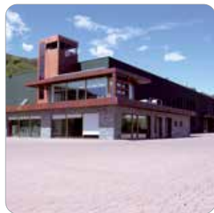
NEW PRODUCTION UNIT San Maurizio d'Opaglio (NO)
